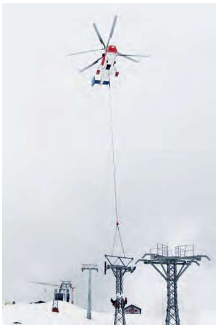
Bei guter Vorbereitung dauert die Demontage einer Stütze nur wenige Sekunden.
