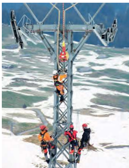
Ein Funker und vier Monteure bilden eine Demontagegruppe. Fotos: SI/Surrer
